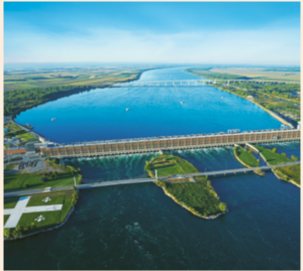
→ CENTRALE HYDROÉLECTRIQUE DE BEAUHARNOIS ©HYDRO-QUÉBEC
